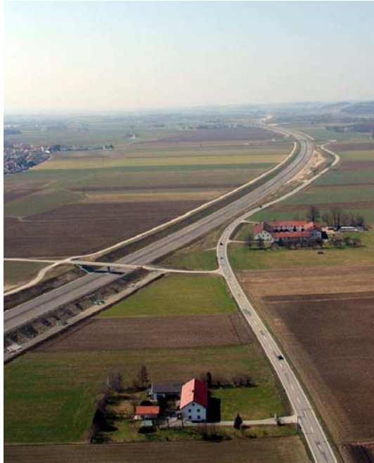
A94; Trassenverlauf östlich von Erharting
