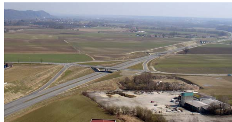
A94; Anschlussstelle bei Töging
